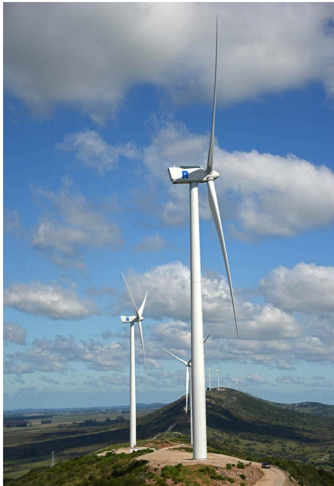
Figura III.1: Modelo de turbina considerado (torre 78m)
