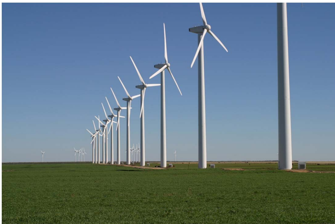
Figura 4 - Aerogenerador de eje horizontal con 3 aspas en disposición típica.
