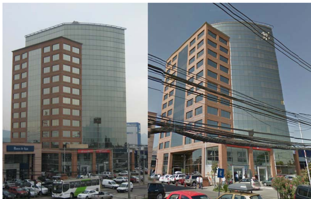
Figura III-1: Fotografías Panorámicas del Edificio Santiago Norte. [Fuente: Elaboración Propia]
