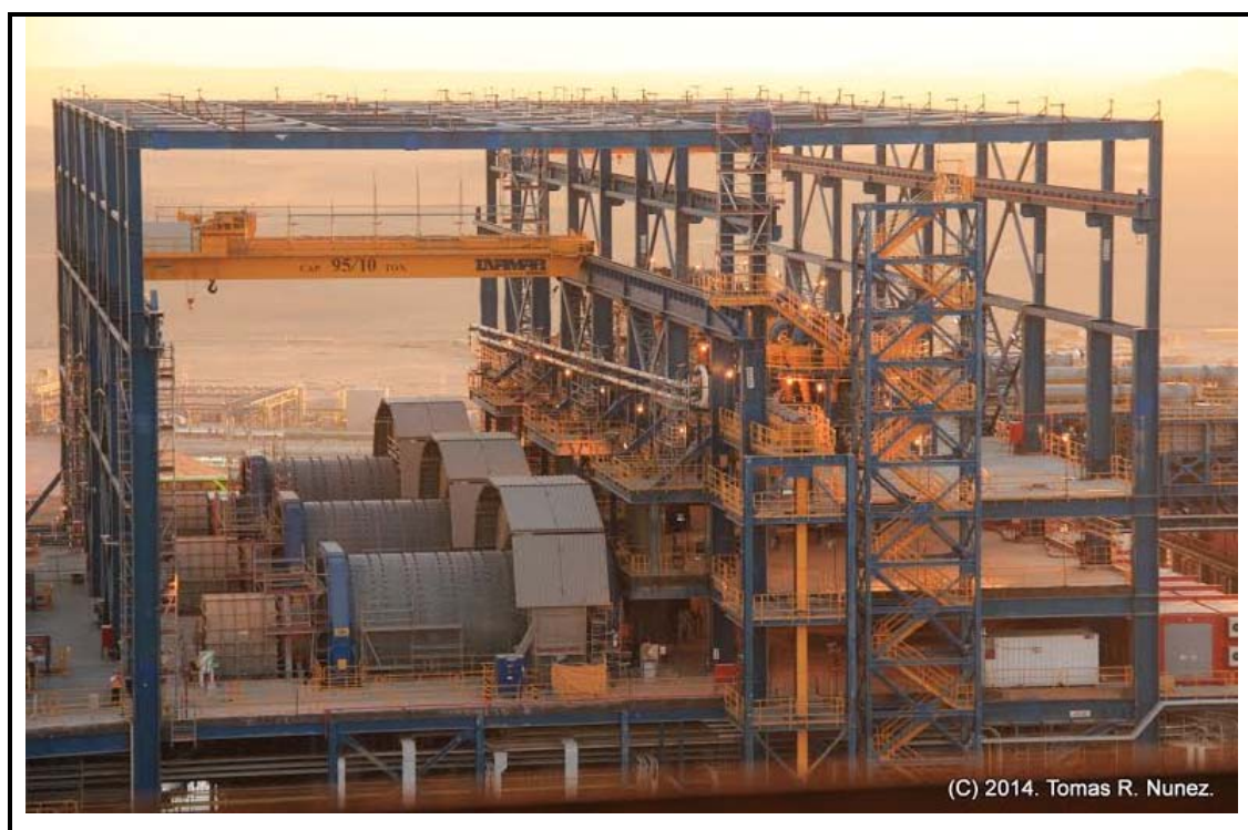
Figura II-1. Vista General del Edificio de Molienda.
