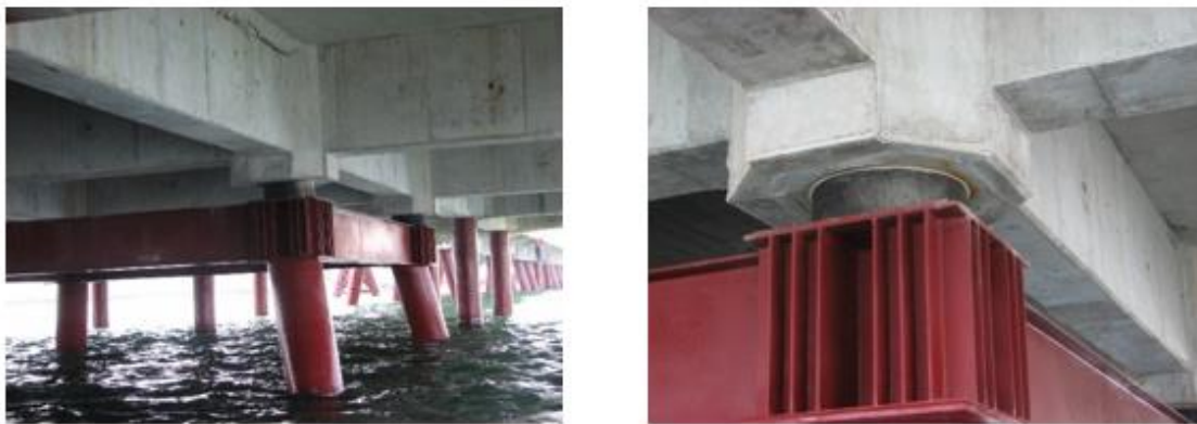
Figura II-5: Muelle Sur Puerto Coronel
