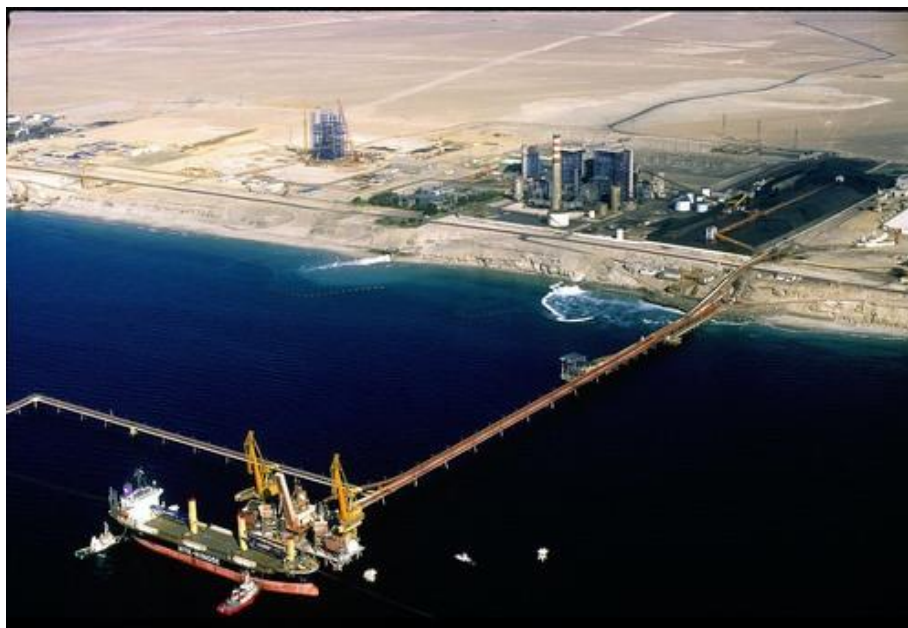
Figura II-2: Puerto de Mejillones
