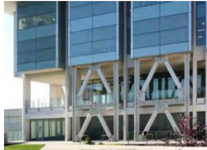
Figura III.1.i Retrofit biblioteca Marriott, Universidad de Utah, EE.UU. [Crisafulli, 2014]
