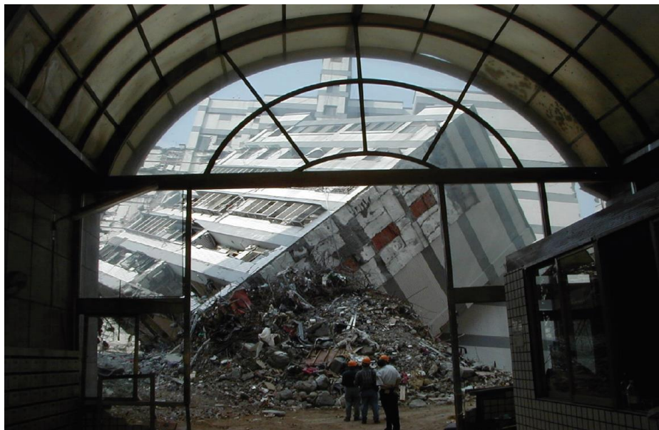
Figura VII.4.1.a Imagen referencial de un edificio bajo estado de colapso [FEMA, 2012]
