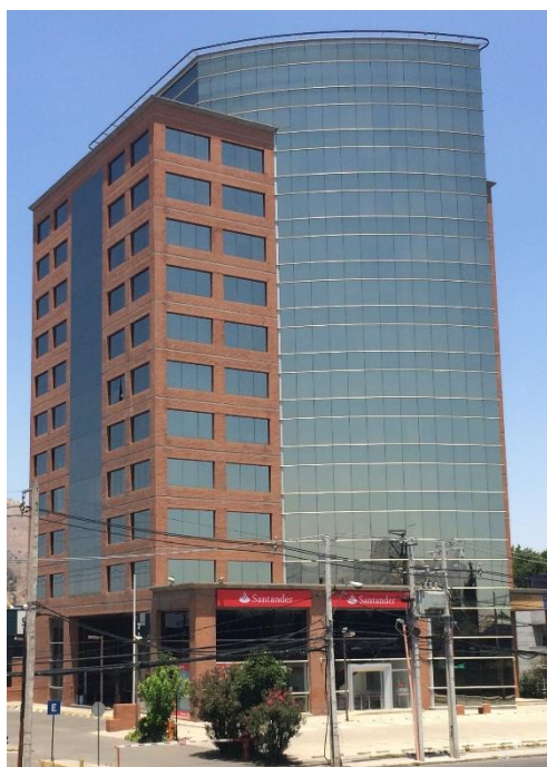
Figura III-1: fachada nororiente edificio Santiago Norte
