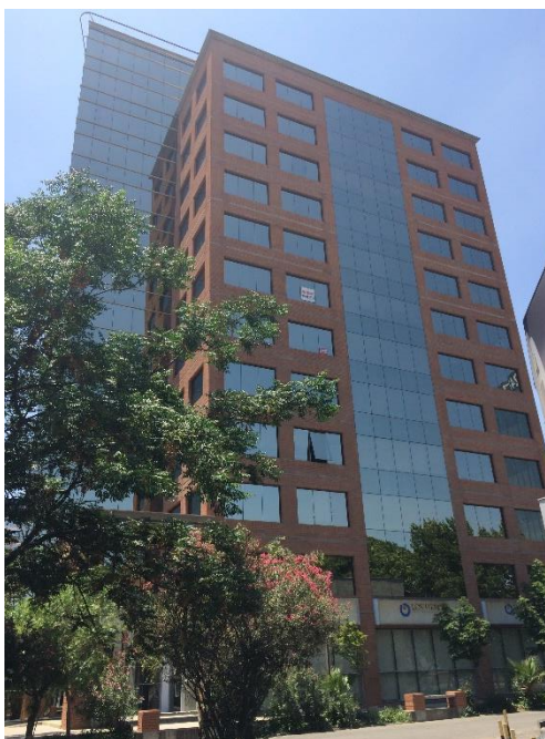
Figura III-3: fachada poniente edificio Santiago Norte.
