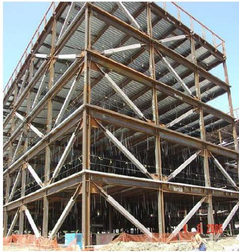
Figura III.7: Edificio con diagonales de pandeo restringido.
