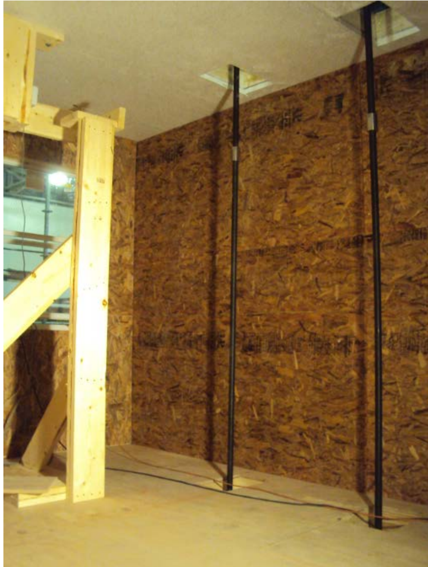
Figura III-62: Vista al interior de un módulo, se aprecian tensores \phi=36\text{mm} para aplicación de carga axial.
