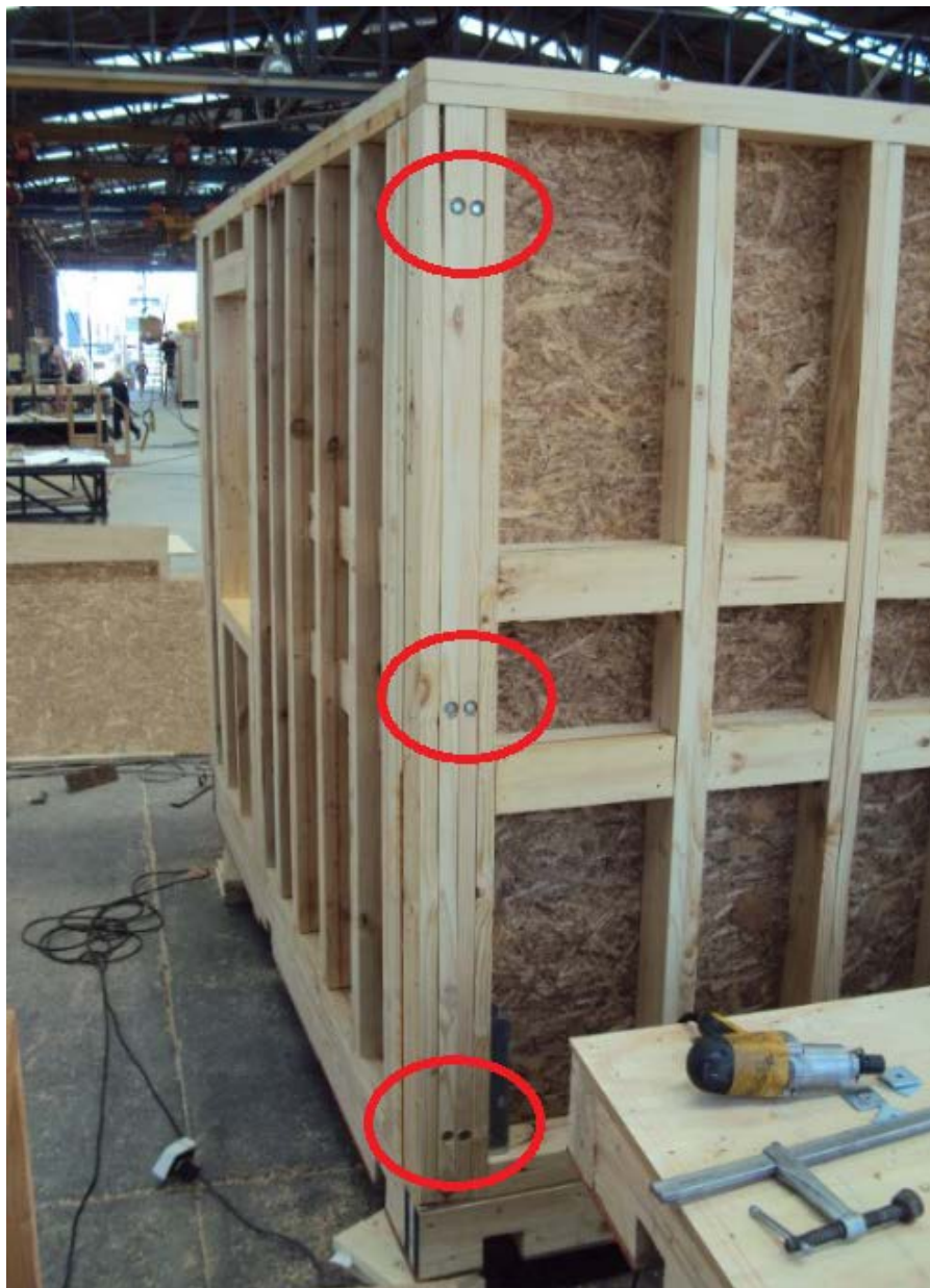
Figura III-44: Detalle de conexión entre muros perimetrales longitudinal y transversal de Módulos en ensayo 3D, se resaltan en rojo las tres ubicaciones de conexión.
