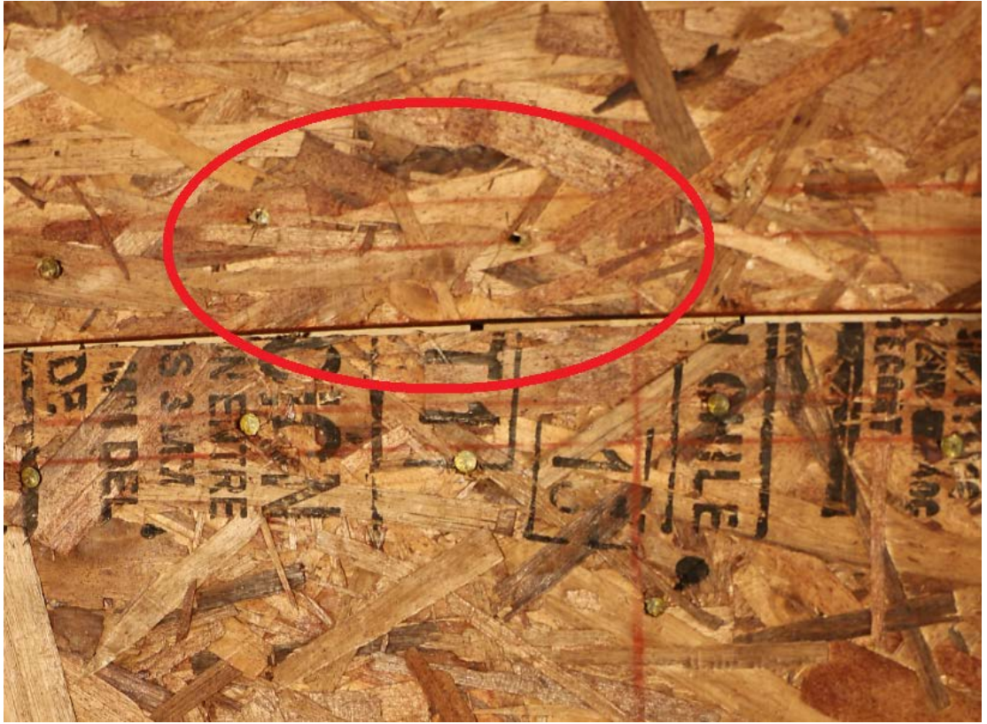
Figura IV-86: Falla por Fatiga al corte del clavo.
