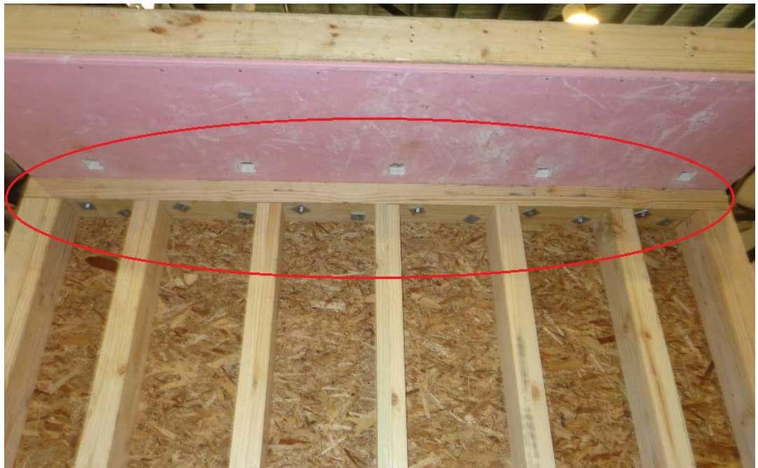
Figura III-30: (Sup) Detalle de conexión entre muros y diafragmas horizontales con tirafondos, (Inf) Vista Lateral del muro con énfasis en conexión escalonada o alternada de tirafondos entre muro y losa de cielo.
