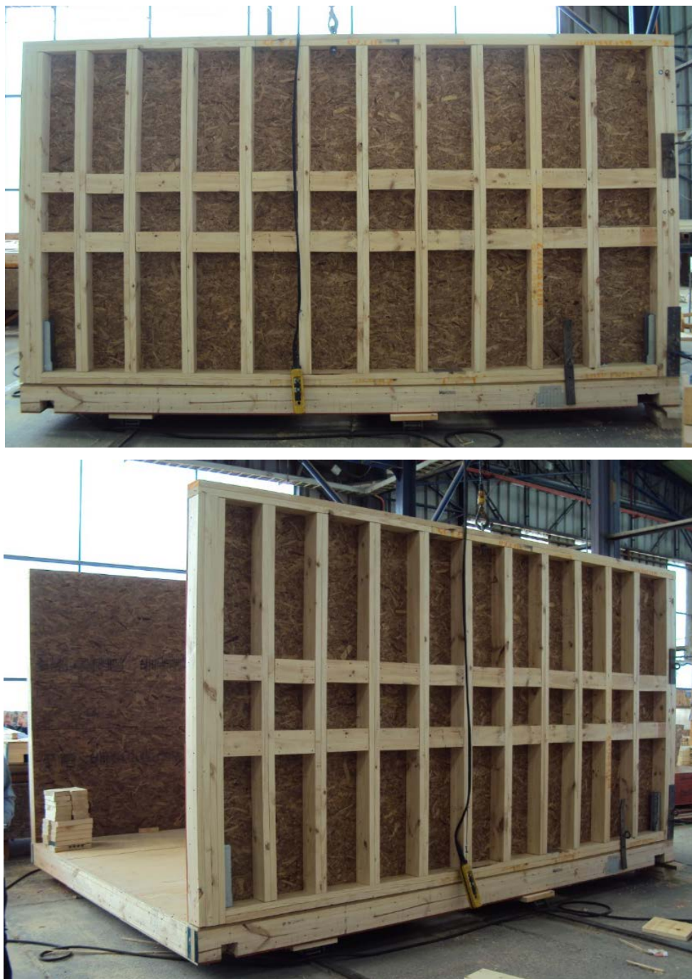
Figura III-40: Vistas del Muro M1 en Módulo.
