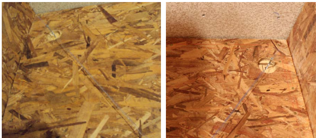
Figura III-68: Arreglo medición de deformaciones esquina superior.
