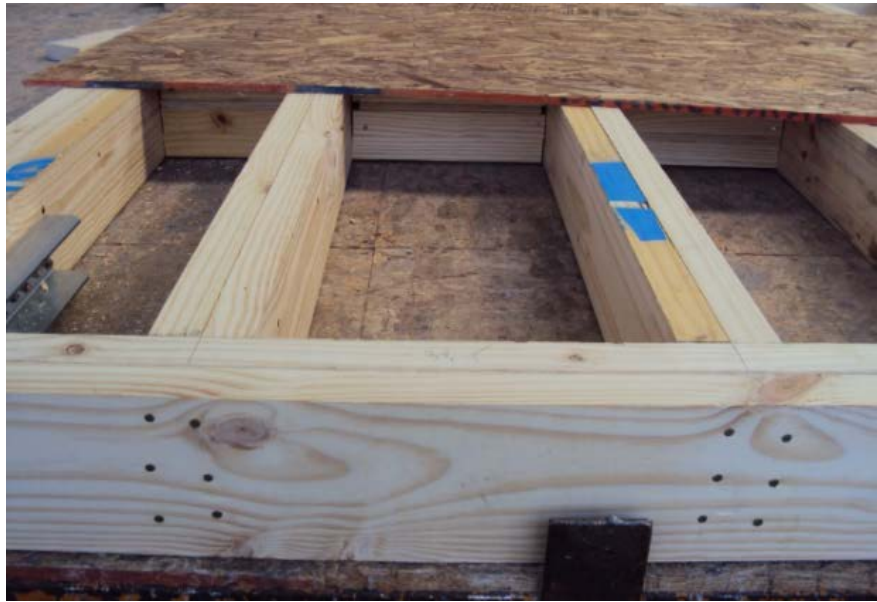
Figura II-11: Conexión adoptada entre Pie Derecho y Solera para los muros de ensayo del proyecto.
