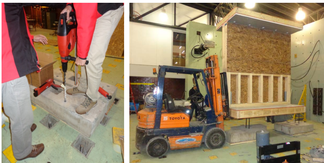
Figura III-49: (Izq) Instalación de barras de anclaje de conector Hold-Down HDQ8, (Der) Probeta de Muro No. 1 conformada momentos antes de su ubicación definitiva en las bases de hormigón.
