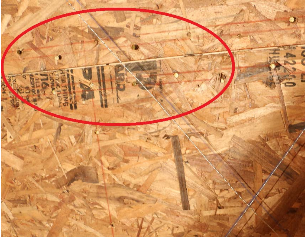
Figura IV-85: Falla por Desclavamiento.
