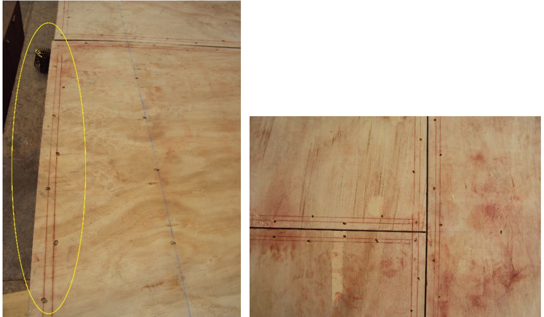
Figura III-37: Losa de Piso Módulos con clavos escalonados cada 100mm.
