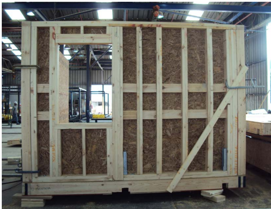
Figura III-42: Muro M2 en Módulo antes de instalar la losa de cielo.
