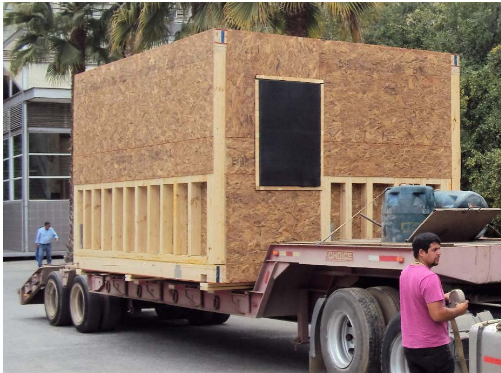
Figura III-48: Módulo Prefabricado de 3.54x4.72x2.86m.
