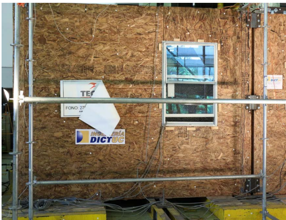
Figura IV-82: Módulo Sur Después del ensayo.
