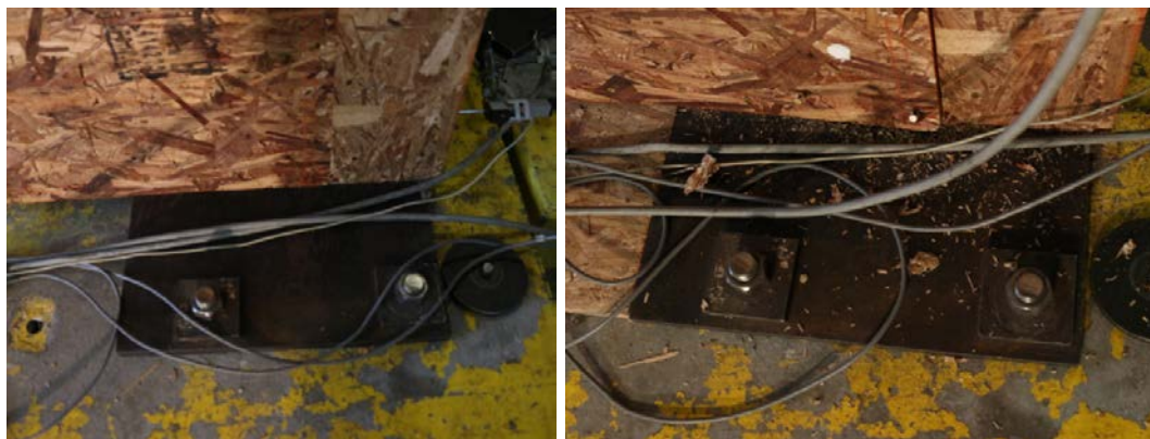
Figura IV-83: Antes y Después, efectos de amortiguamiento y disipación de energía (Base Módulo Norte).
