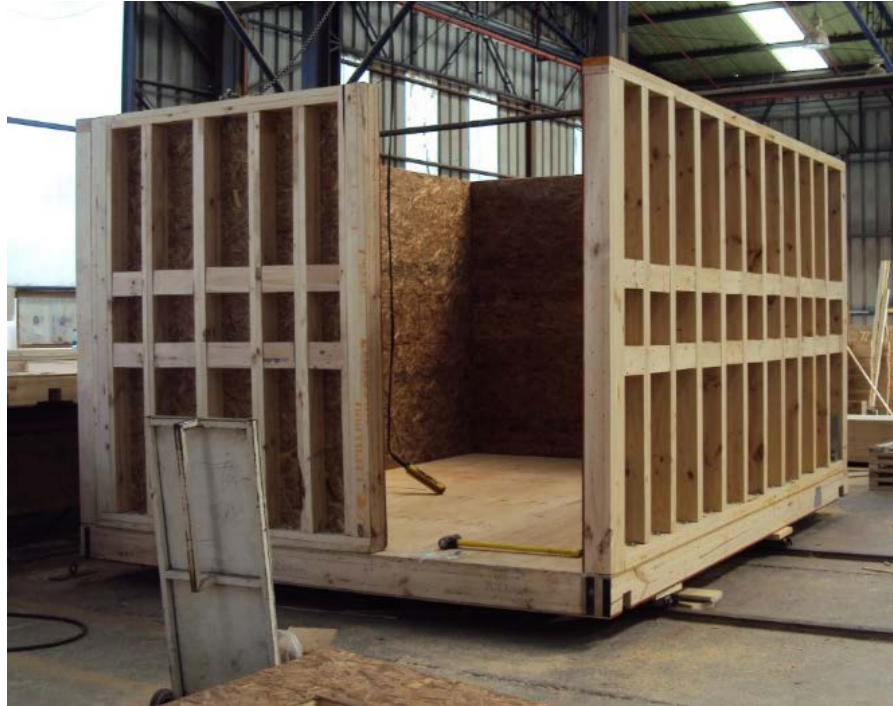
Figura III-41: Muro M3 y M1 en Módulo antes de instalar la losa de cielo.
