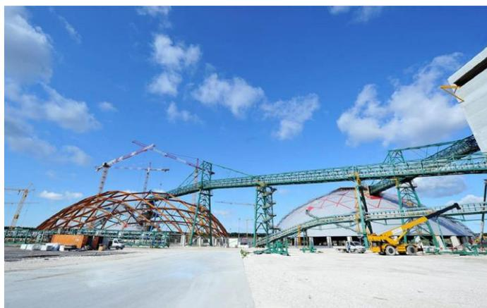
Figura I-1: Construcción domos 144 m de diámetro de madera, Brindisi, Italia (ENEL, 2015).
