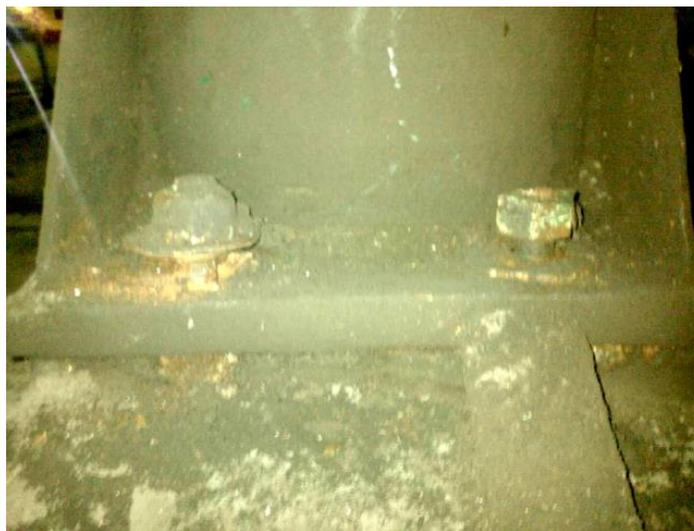
Figura I-2: Falla de pernos de anclaje sin longitud expuesta (Soules et al. 2016)
