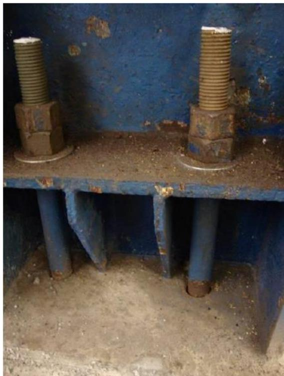
Figura I-1: Pernos de anclaje plastificados (Soules et al. 2016)
