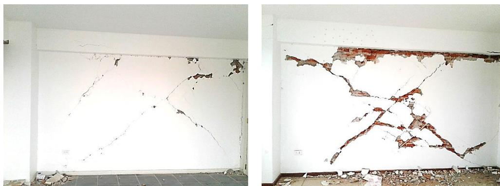
**Figura 2-6. Falla de la albañilería en el plano. Edificio en Bahía de Caráquez luego del sismo S16A**
