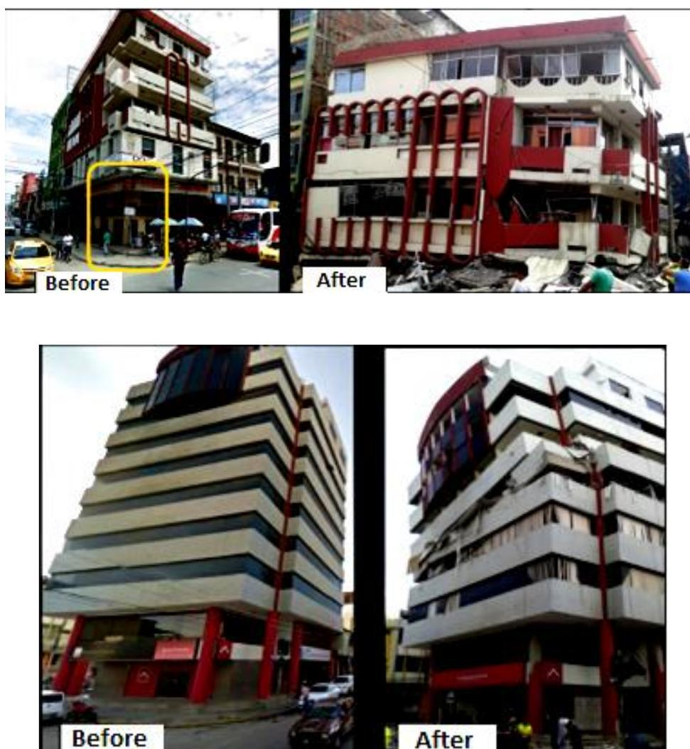
Figura 2-2. Ejemplos de colapso por piso blando en S16A. Fotografías (Castañeda & Mieles, 2017)
