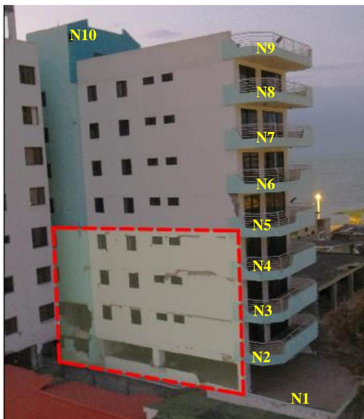
Figura 4-33. Daño en albañilería concentrado en su mayoría en los primeros pisos.
