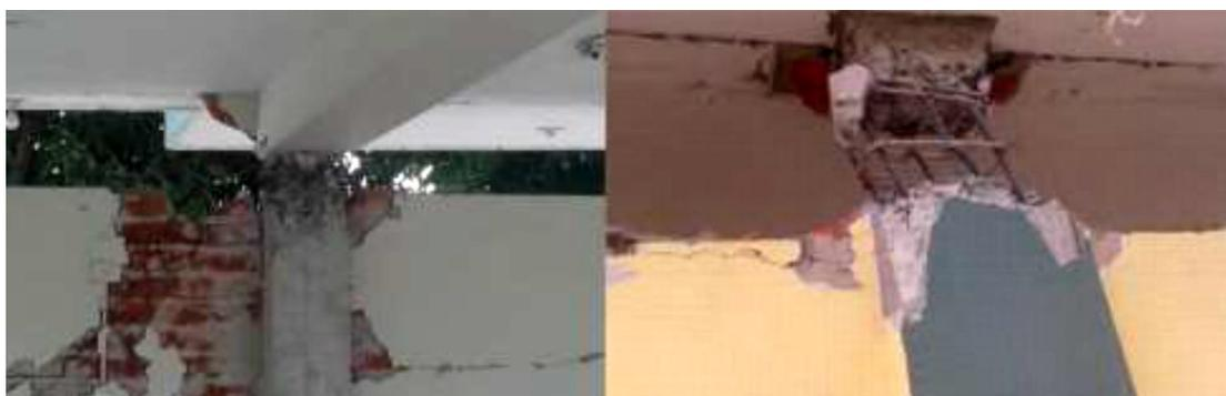
Figura 2-3. Daño por columna corta en edificios de Portoviejo (Aguiar, 2016)
