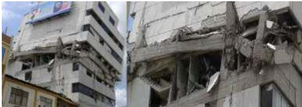
Figura 2-4. Edificio con mecanismo de falla por columna débil-viga fuerte (Aguiar, 2016)
