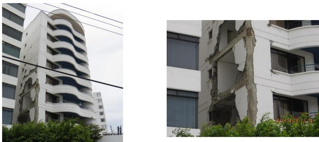
**Figura 2-7. Falla de albañilería fuera del plano. Edificio de Bahía de Caráquez luego del sismo S16A**
