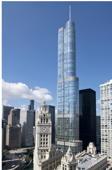
Figura 1.2. Trump Tower. Edificio con núcleo y outriggers de concreto (Skidmore, Owings & Merrill LLP, s.f.).
