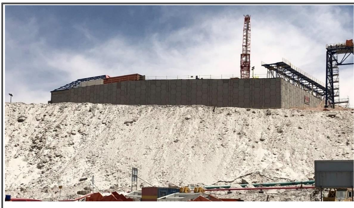
Figura 1-1: Vista general del muro TEM. Extraído de (CMGI, 2019).
