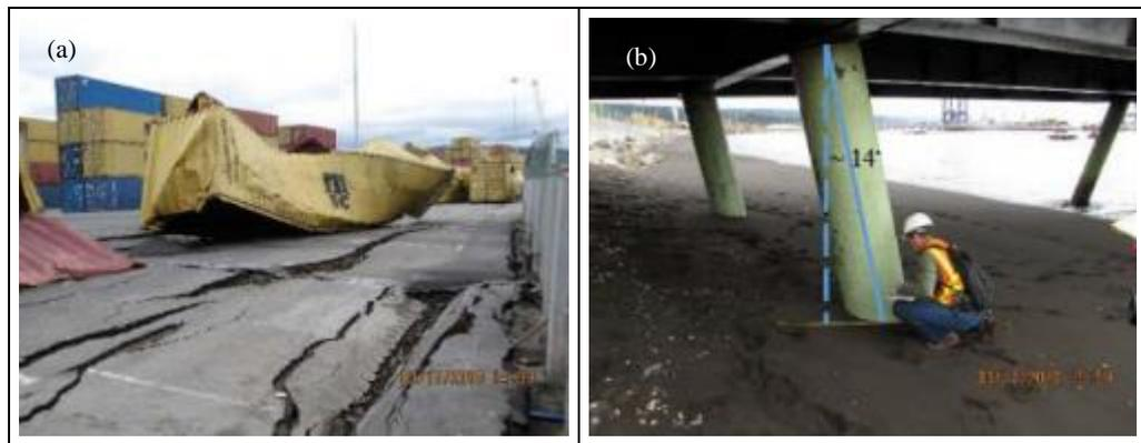
Figura 1-6: Daños observados en muelle norte puerto Coronel, (a) Grietas y asentamientos en pavimentos, (b) Rotación de pilotes de fundación (Ledezma y Tiznado, 2017)
