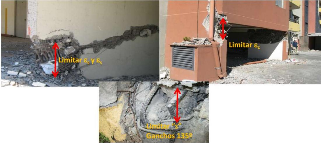
Figura 1.3: Daños en muros con confinamiento inadecuado (ICH 2020).
