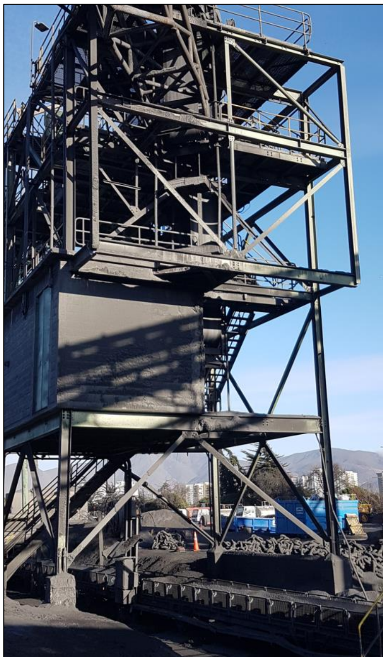
Figura II-3: Vista lateral (ejes 2 y 3) de la estructura
