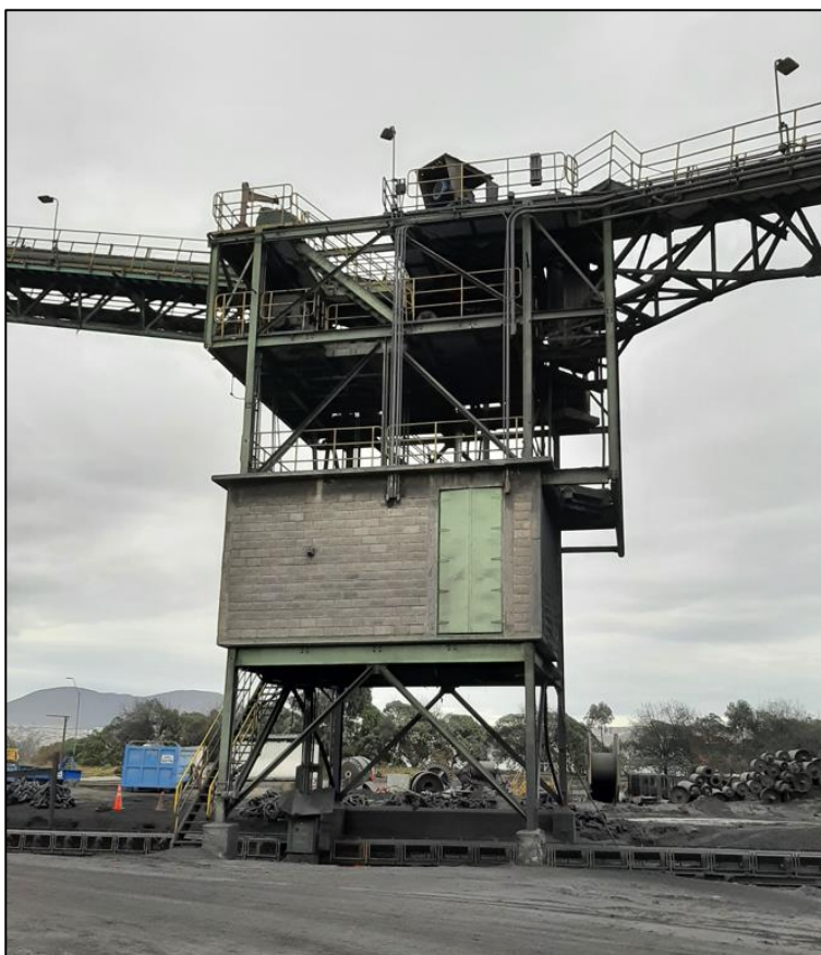
Figura II-2: Vista frontal (eje A) de la estructura
