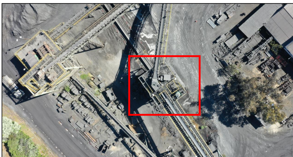
Figura II-1: Área de emplazamiento de la estructura
