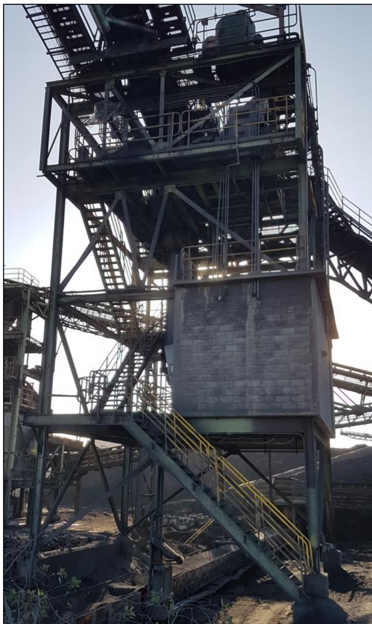
Figura II-4: Vista lateral (ejes 0 y 1) de la estructura
