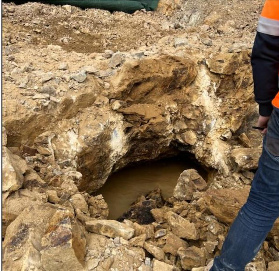
Figura II-7: Vacío superficial encontrado durante la excavación de la viga de coronamiento.
