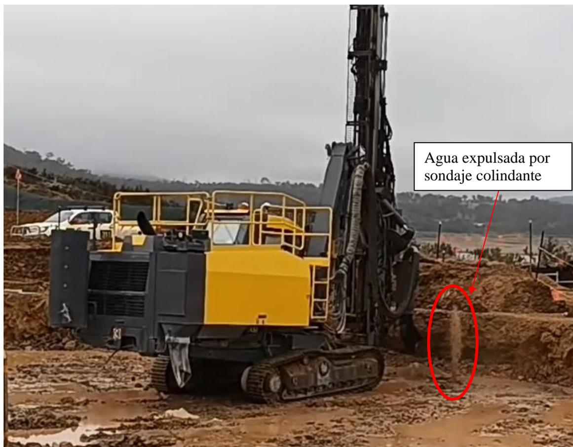
Figura II-8: Agua expulsada durante trabajos de perforación en el gate shaft.
