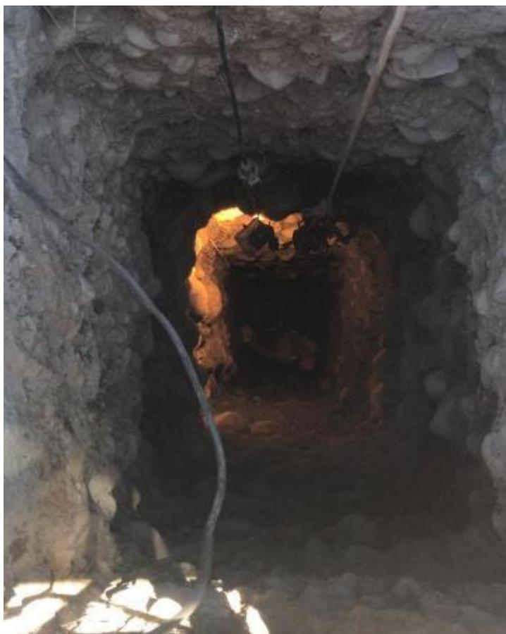
Figura I-1: Excavación manual de pozo vertical (<https://www.socalzadoaguilar.cl/>).
