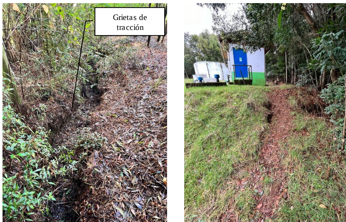
Figura 3. Coronación del talud.
